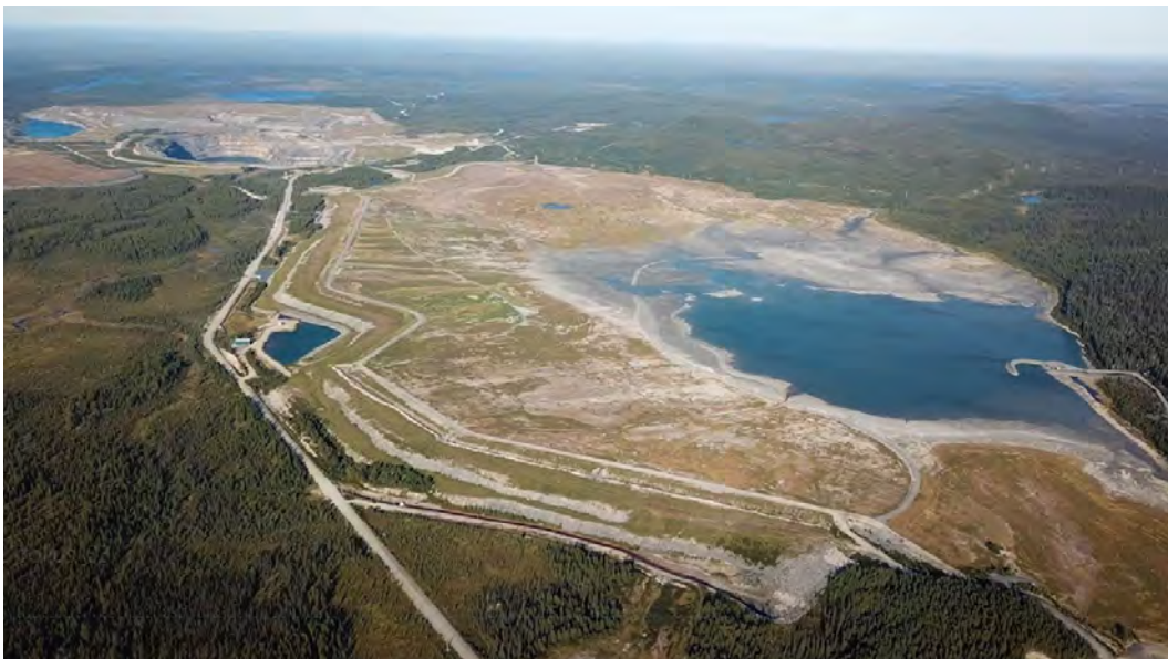
Vue du parc à résidus restauré
